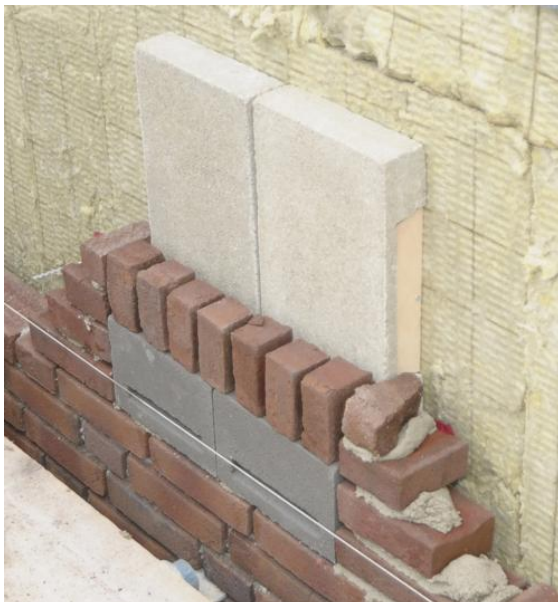
In metselen van prefab vleermuiskasten (houtbeton)
