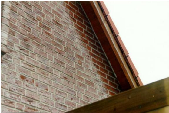
Scherpe begrenzing tussen het beregende en met zon beschenen gedeelte en het droge deel van de gevel
